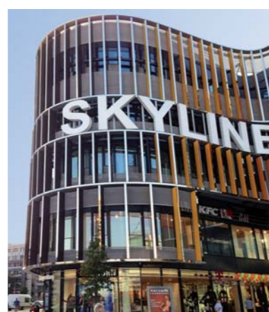
Unterstreicht das Lebendige der Bauform: die Lamellenfassade.
