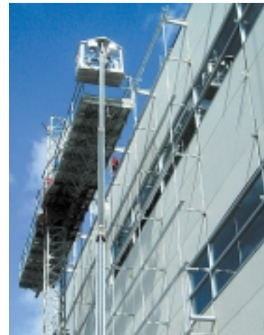
Montage der Stahlkonstruktion
