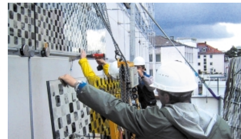
Über zwanzig Monteure realisierten die sich auf 3 500 m 2 erstreckende Glasfassade. Es wurden 545 Stück rechteckige und 107 Stück gebogene Glasscheiben mit einem Einzelgewicht von über 220 kg verbaut.
