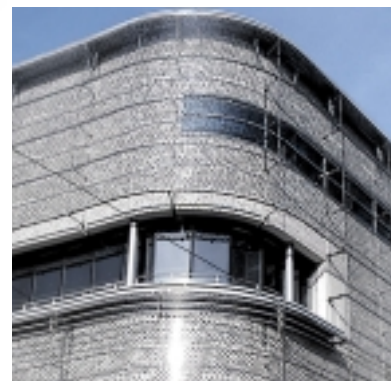
Gebogene Fassade an den Gebäudeecken
