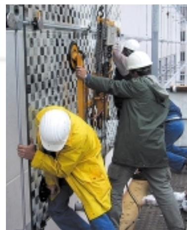
Über zwanzig Monteure realisierten die sich auf 3 500 m 2 erstreckende Glasfassade. Es wurden 545 Stück rechteckige und 107 Stück gebogene Glasscheiben mit einem Einzelgewicht von über 220 kg verbaut.
