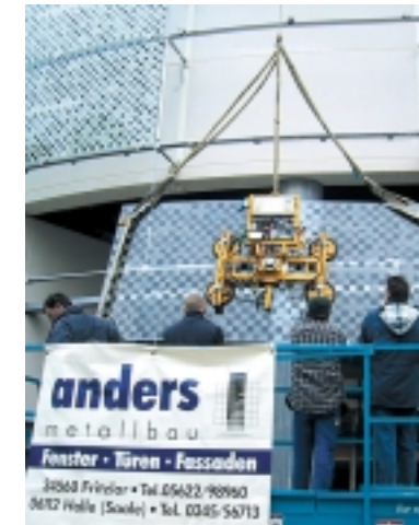
Einsetzen der Verglasung mit Sauganlage.
